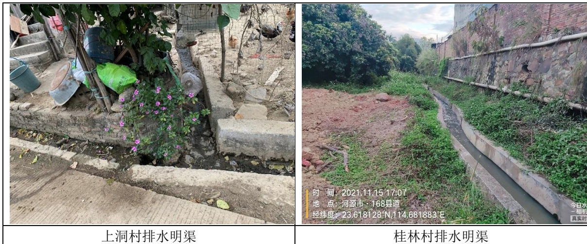
图3.5-6 污水收集输送管道为明渠
