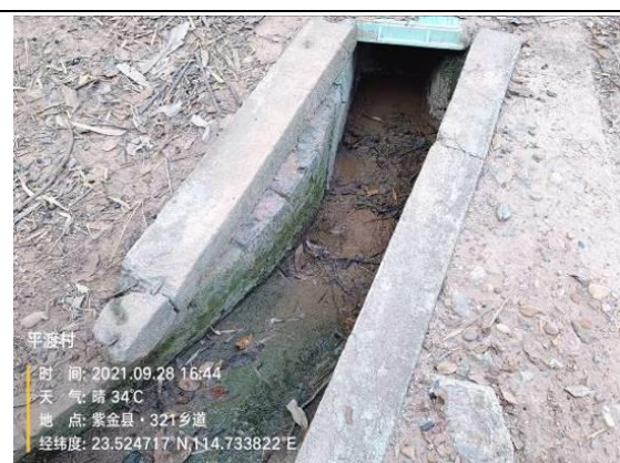
图3.5-4 排水渠接入污水主管
