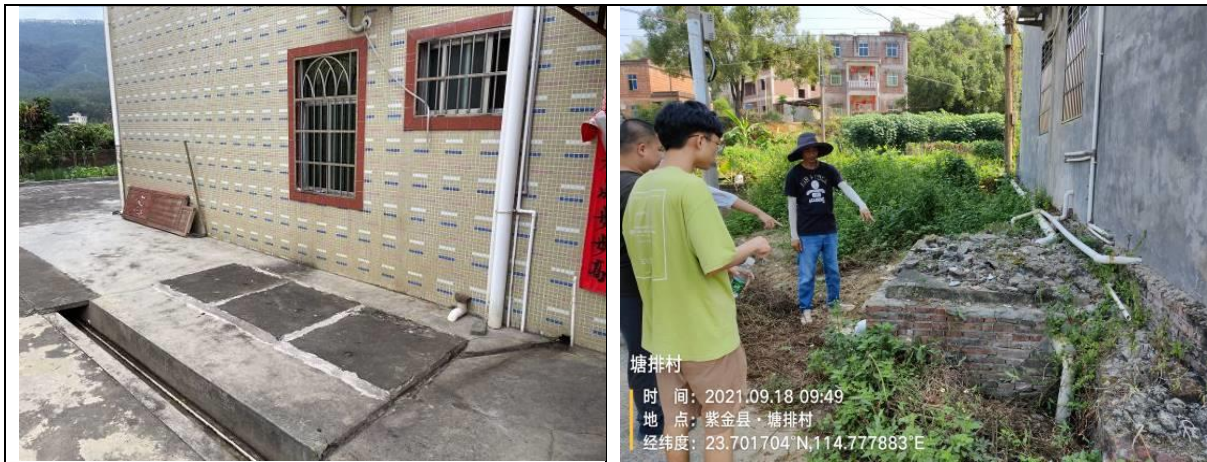
图3.5-1 农户已建三格化粪池
