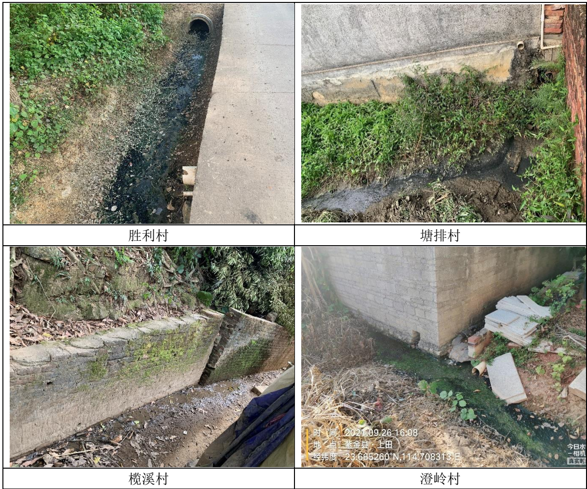
图3.5-7 未建设污水收集输送系统
