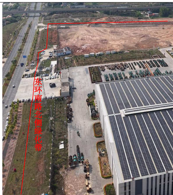
沿东环南路北侧绿化带内往东走线
