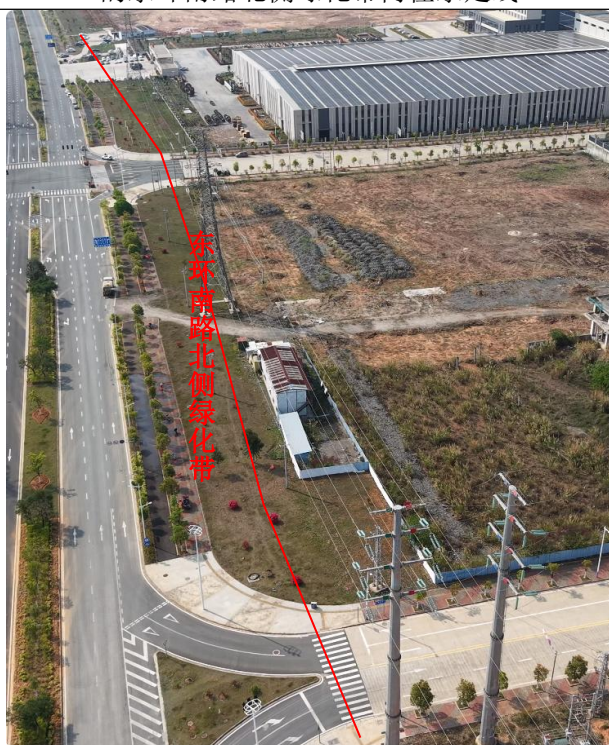
沿东环南路北侧绿化带内往东走线
