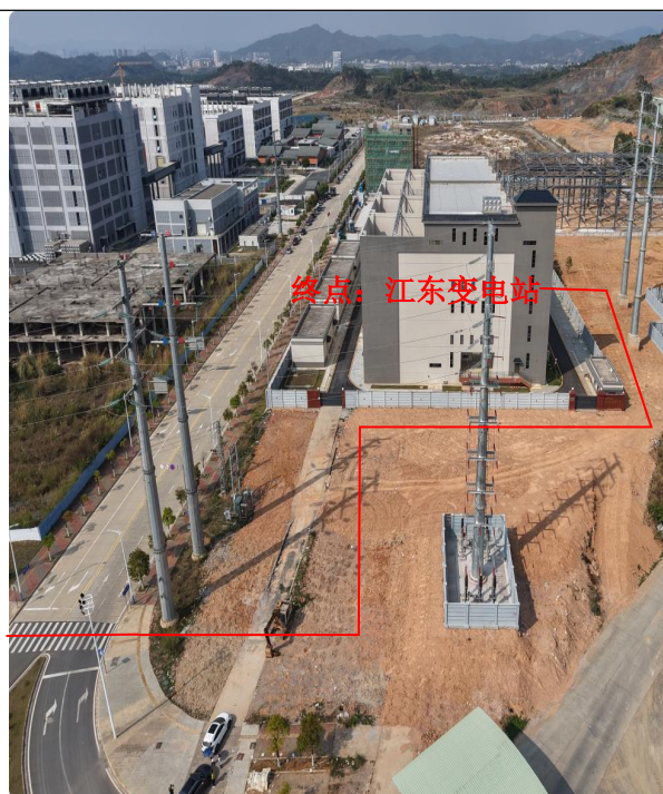
线路终点：江东变电站
