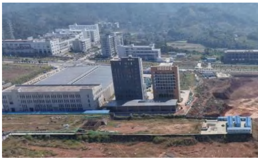
项目南侧工业园内规划厂房
