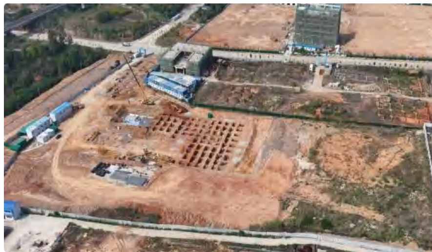
项目北侧工业园内规划厂房
