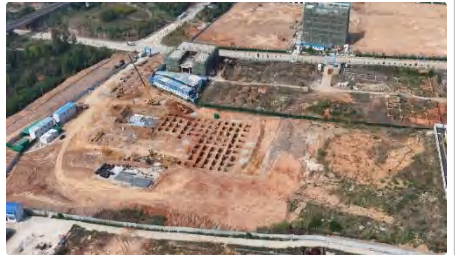
项目北侧工业园内规划厂房
