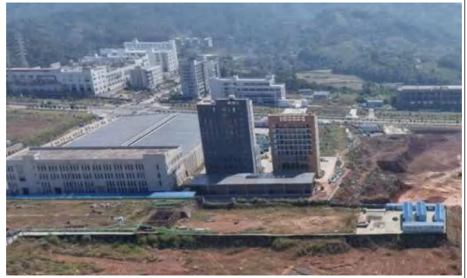
项目南侧工业园内规划厂房
