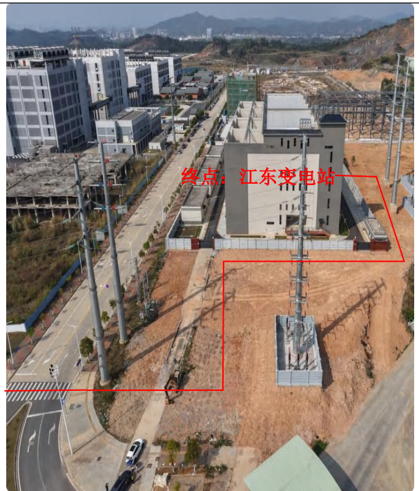
线路终点：江东变电站
