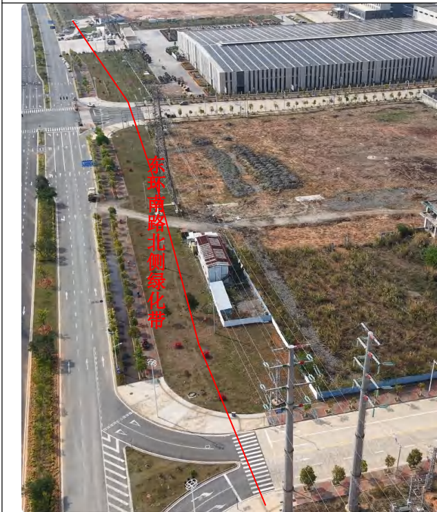
沿东环南路北侧绿化带内往东走线
