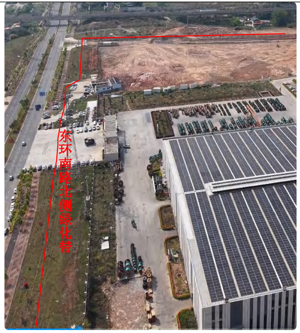
沿东环南路北侧绿化带内往东走线
